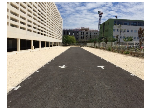
Parking – zones perméables alvéoles PEBD + gravillons clairs
