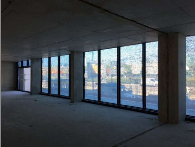
Mur rideau alu Façade Nord
