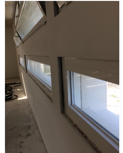
↑ Mise en œuvre de l'isolant en cours
