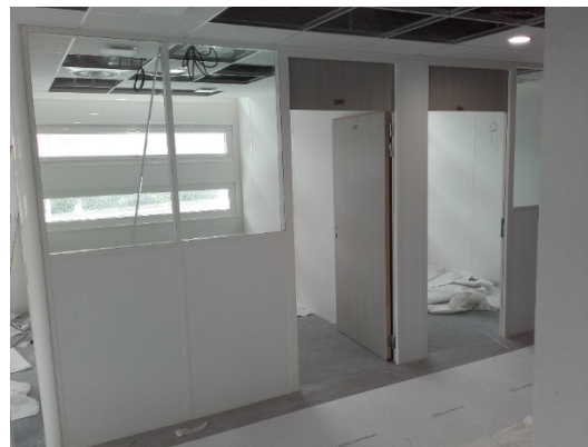
Cloisonnement intérieur, parois vitrées
