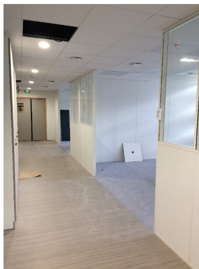
Faux plafond en plaque de plâtre
