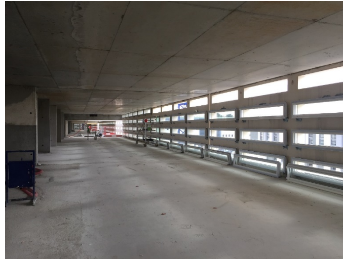
Menuiseries alu Façades Sud, Est, Ouest
