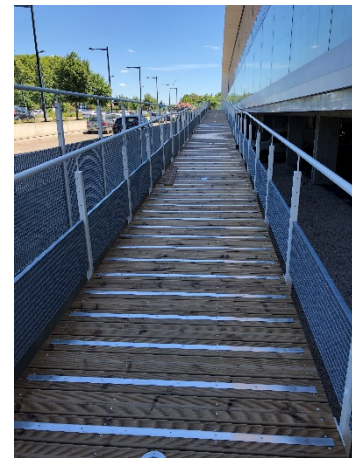
Rampe d'accès PMR
