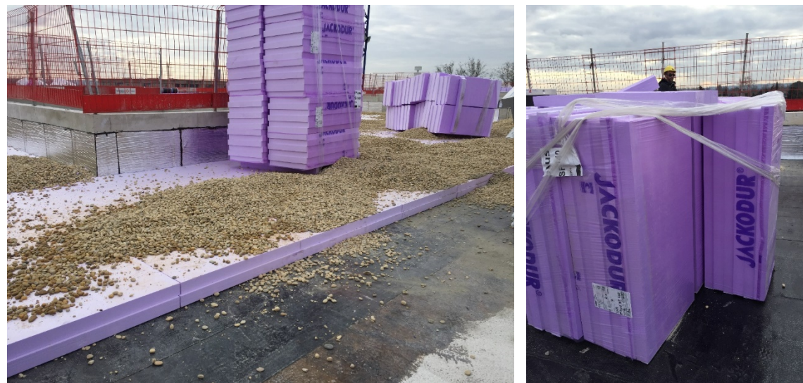
Isolant de toiture (XPS), 2 x 7cm
