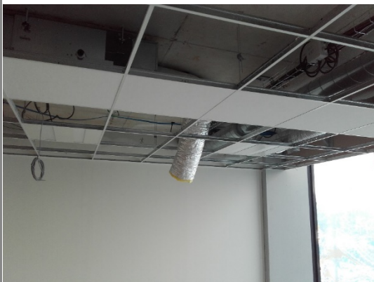
Mise en œuvre des faux plafonds
