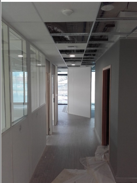
Mise en œuvre des faux plafonds
