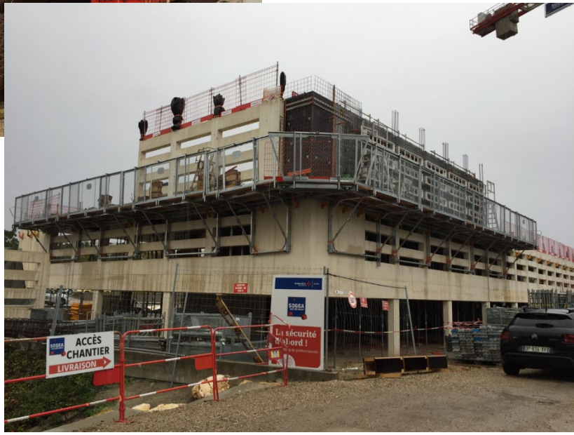
Avancement des façades en béton blanc
