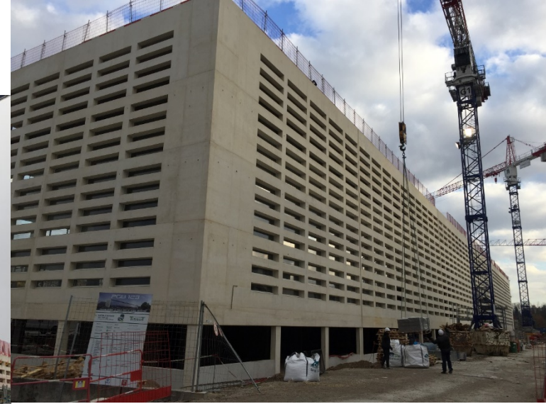
Façades en béton blanc finalisées
