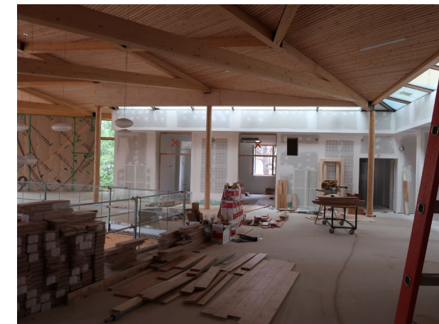
Mise en place des revêtements de sol – Finition de l'entrée principale
