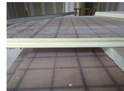
Installation du plancher chauffant/rafraichissant dans la partie neuve
