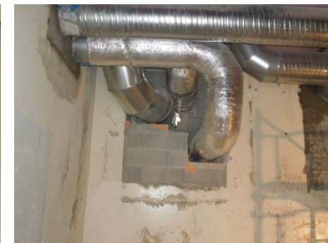
Mise en place des réseaux aérauliques dans l'existant
