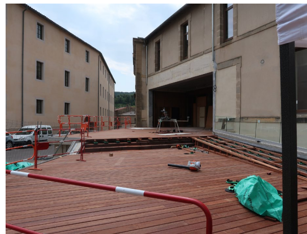
Mise en place des revêtements de sol – Finition de l'entrée principale
