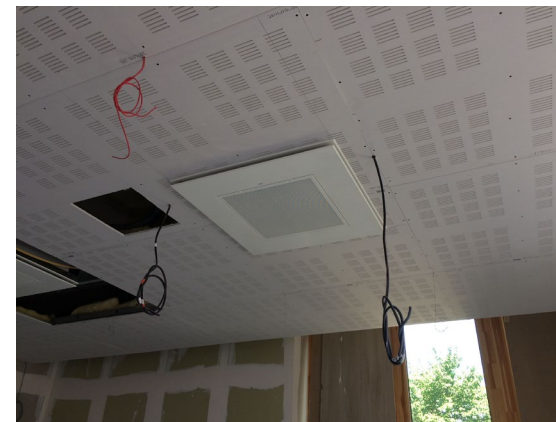
Mise en place des doublages en plâtre
