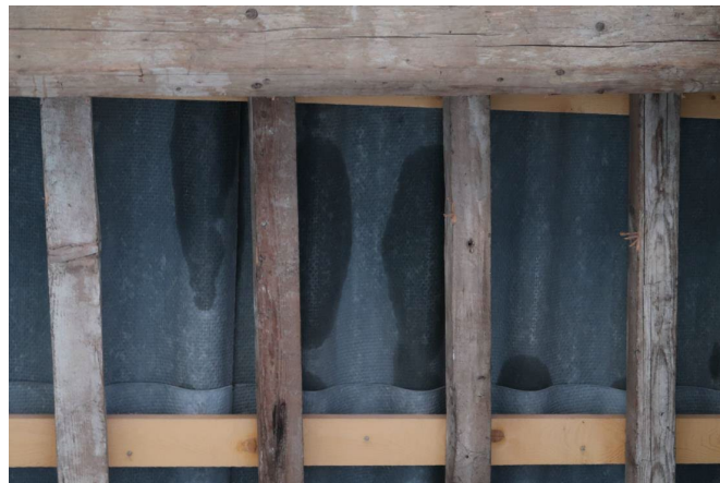
Finition de la Mise en place de l'étanchéité du bâtiment (Certaines zones restantes à traiter)
