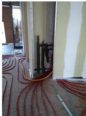
Installation du plancher chauffant/rafraichissant dans la partie neuve
