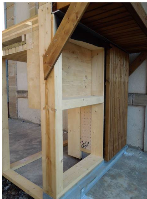
Echantillon ossature bois mis en place pour une bonne intelligence de chantier
