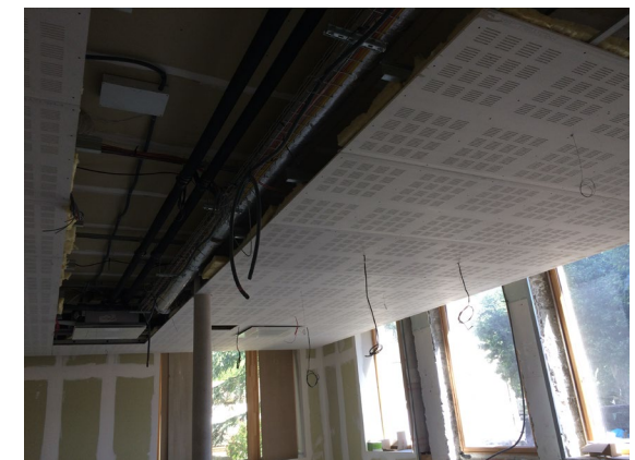
Mise en place des doublages en plâtre
