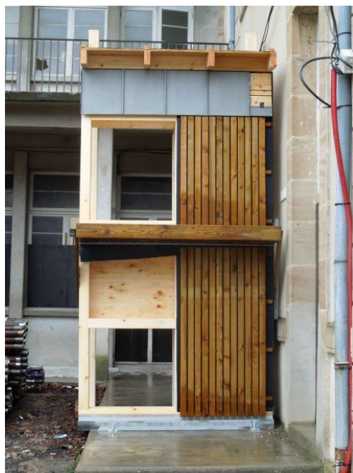
Echantillon ossature bois mis en place pour une bonne intelligence de chantier
