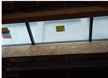
Mise en place des vitrages SageGlass
