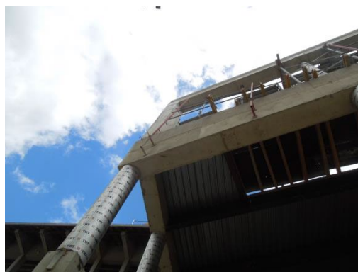
Mise en place des poteaux porteurs et de l'extension neuve
