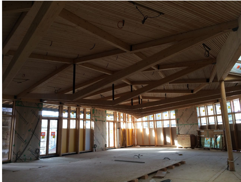
Mise en place des vitrages SageGlass
