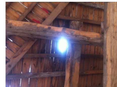
Début de la rénovation de la charpente existante
