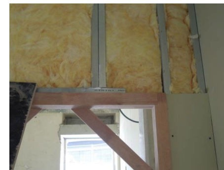
Pose de l'isolation dans l'existant
