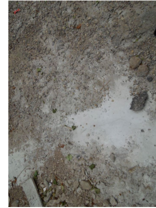
Problème de nettoyage du site : Laitance, gravats, chantier
