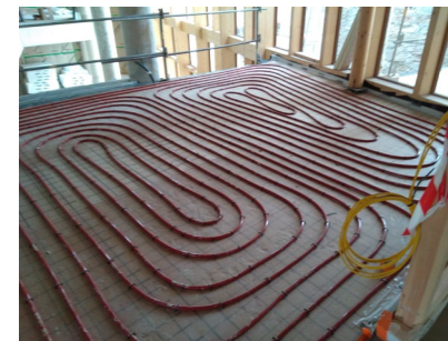
Installation du plancher chauffant/rafraichissant dans la partie neuve
