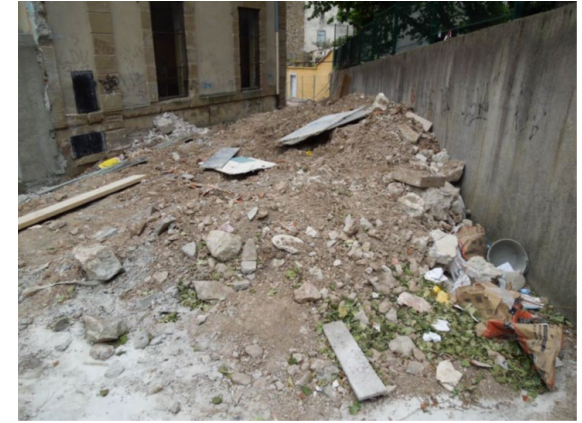
Problème de nettoyage du site : Laitance, gravats, chantier
