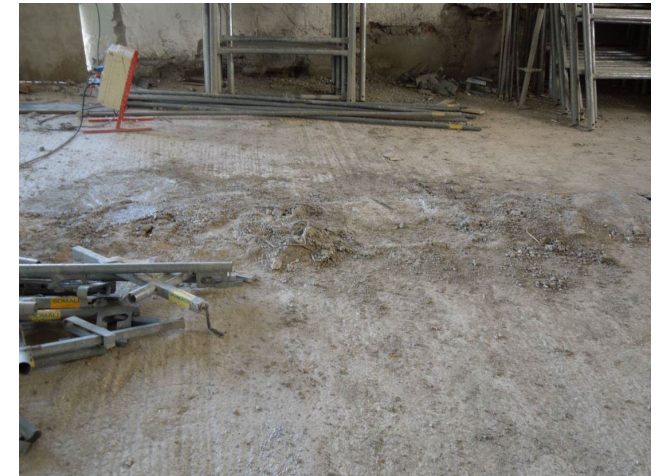
Problème de nettoyage du site : Laitance, gravats, chantier
