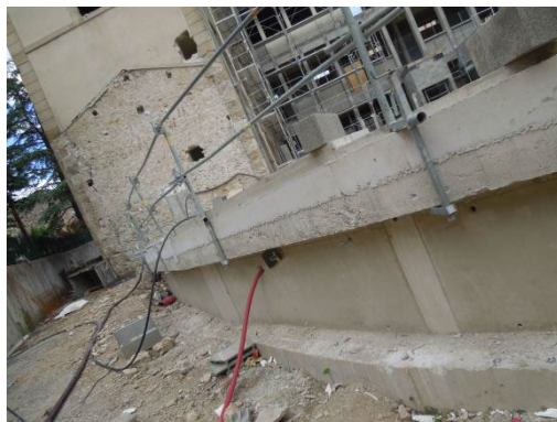
Coulage de la dalle – RDC bas
