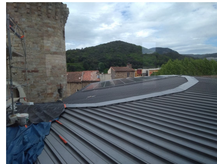
Finition de la toiture (partie neuve) Mise en place des panneaux photovoltaïques
