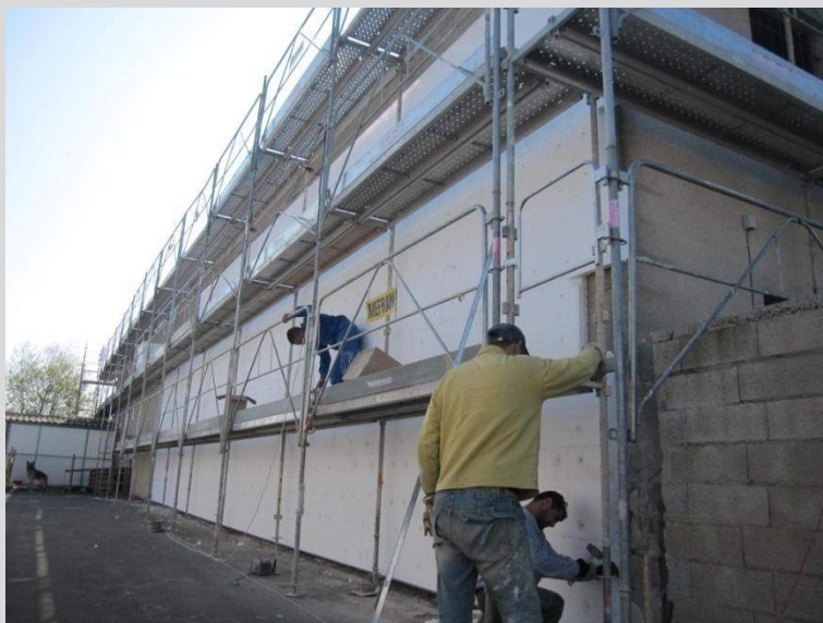
Façade nord : polystyrène
