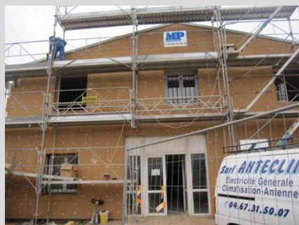
Façade nord : polystyrène
