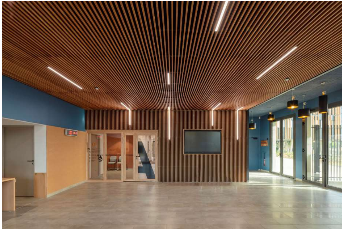
▲ Faux plafond et habillages muraux bois du hall d'accueil
