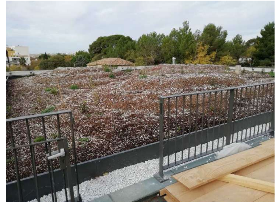
▲ Toiture végétalisée de l'administration
