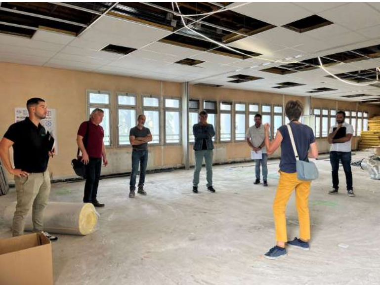
Informations sur « déchets » et « REP » sur chantier
