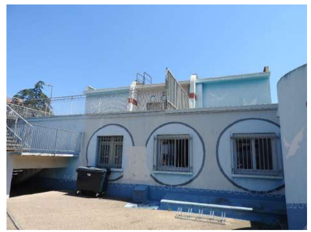
Entrée du bâtiment
