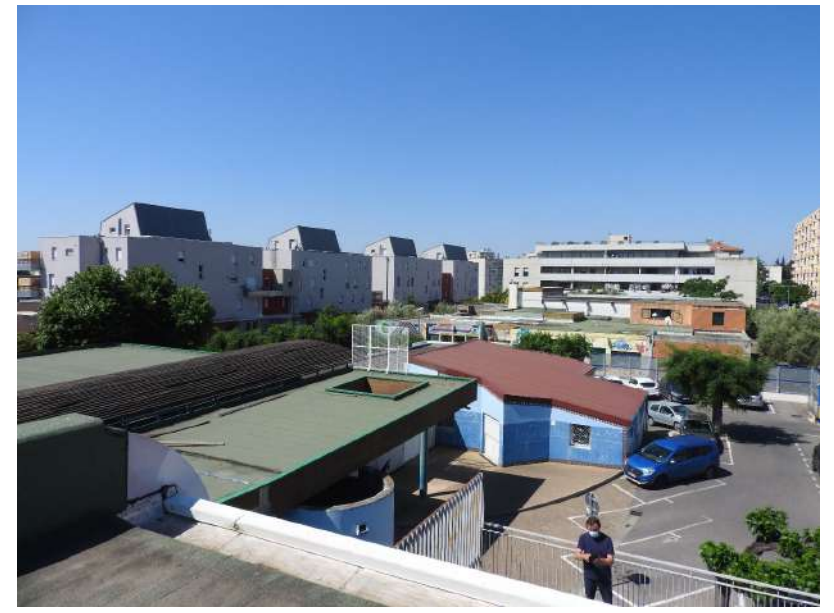
Vue de la toiture
