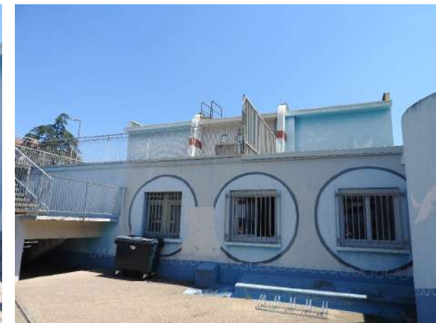
Entrée du bâtiment
