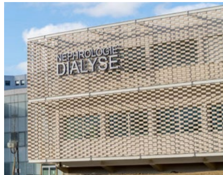
Exemple de résille terre cuite – permet de concilier protection solaire et exigences de sécurité
