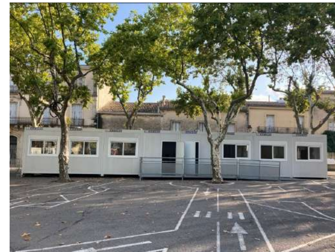
3 bâtiments modulaires sont installés dans la cour de l'école élémentaire (+ 1 modulaire cantine)
