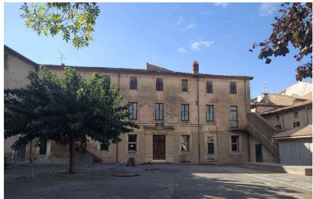
2. Façade de l'aile ouest
