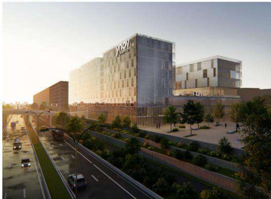
Façade en verre avec sérigraphie : Cette façade bioclimatique protège les façades extérieures du lot Un plancher en caillebotis permet leur maintenance Le dessin de la sérigraphie est inspiré du monde du numérique (Code binaire, pixels...)
