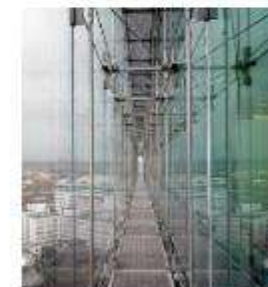
Façade en verre avec sérigraphie : Cette façade bioclimatique protège les façades extérieures du lot Un plancher en caillebotis permet leur maintenance Le dessin de la sérigraphie est inspiré du monde du numérique (Code binaire, pixels...)
