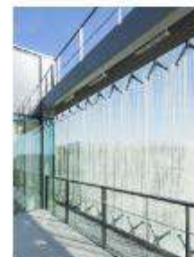
Façade en verre avec sérigraphie : Cette façade bioclimatique protège les façades extérieures du lot Un plancher en caillebotis permet leur maintenance Le dessin de la sérigraphie est inspiré du monde du numérique (Code binaire, pixels...)
