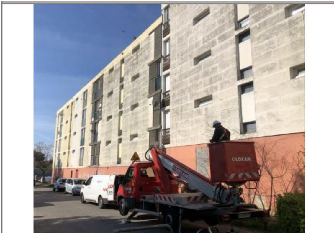
Vue générale d'une des façades de la résidence URANUS
