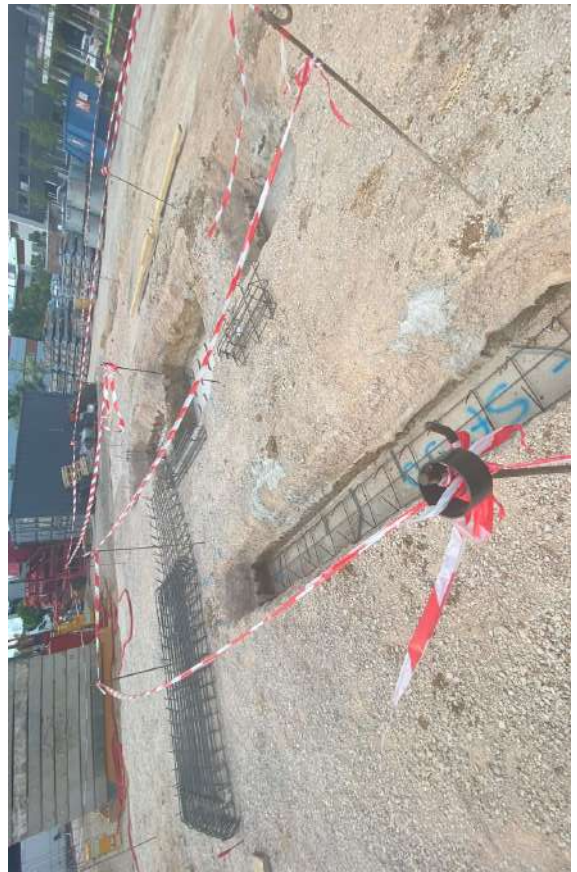
Ferrailage et bétonnage
