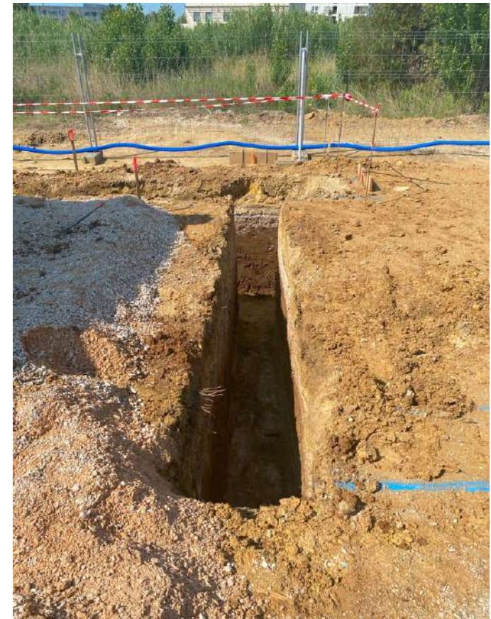
Ouverture fouille et rattrapage en gros béton
