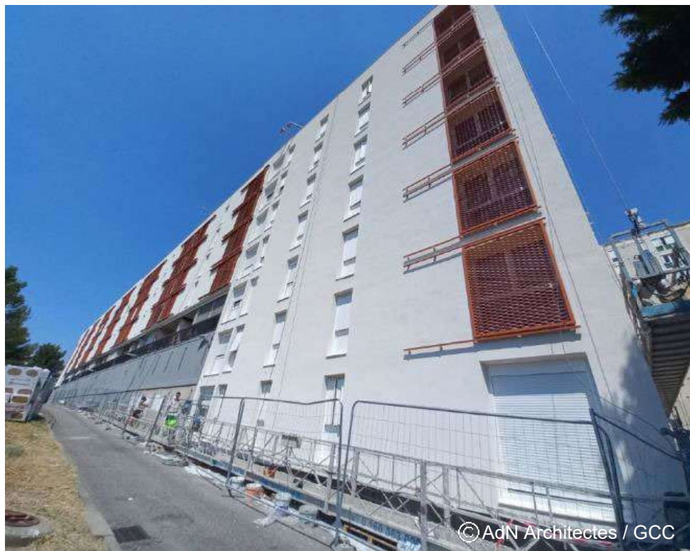
Façade ouest protections solaires
