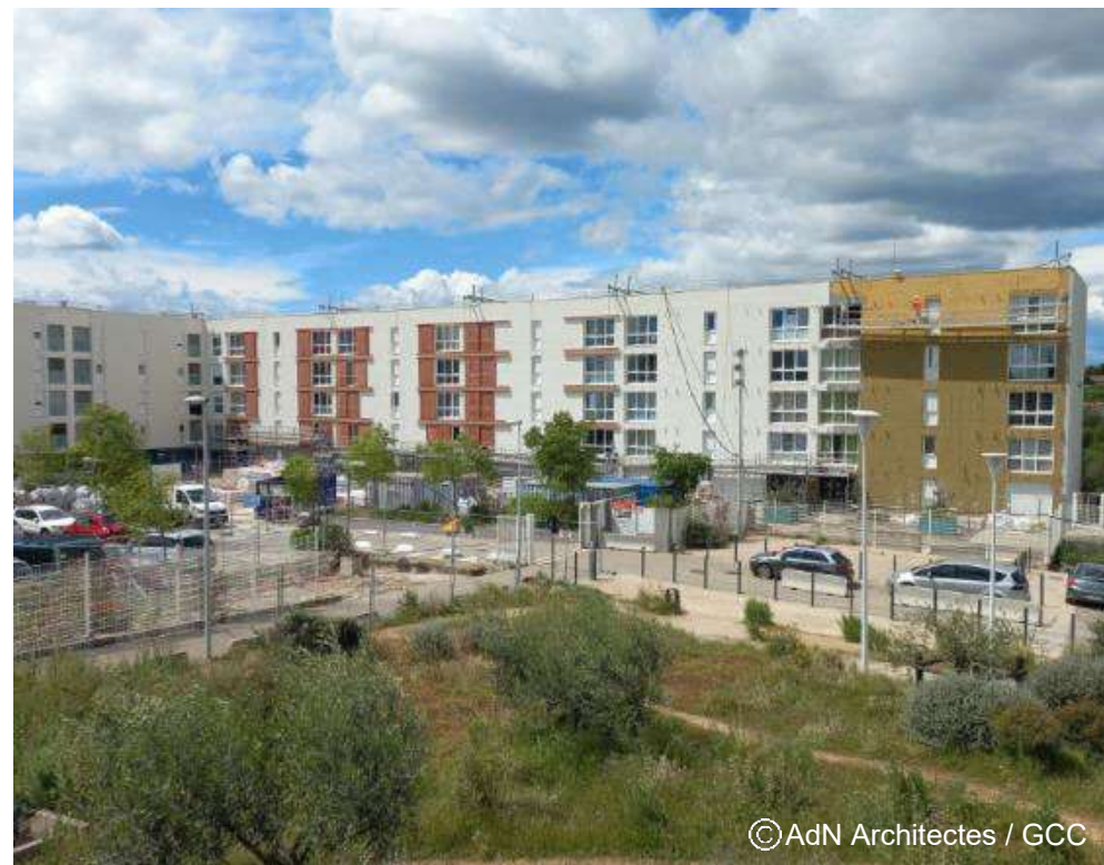
Façade sud ITE et protections solaires
