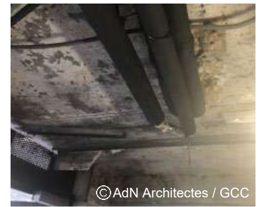
Calorifuge réseau sous-sol
