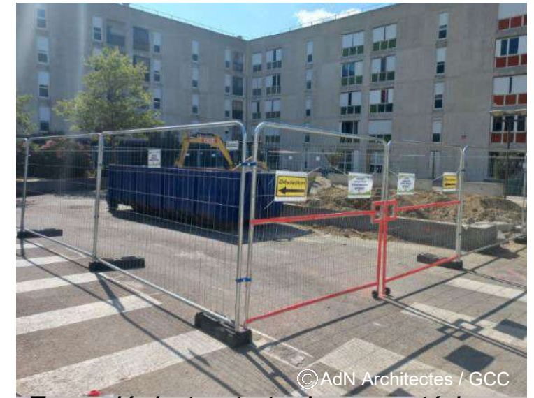
Zone déchets et stockage matériaux
