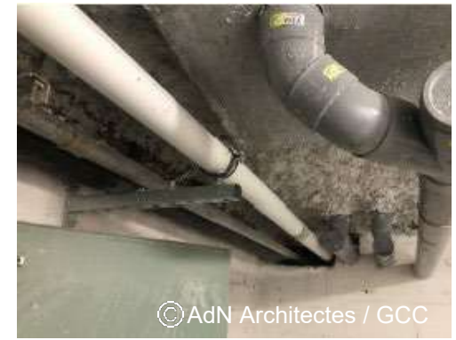
Flocage plancher sous-sol
