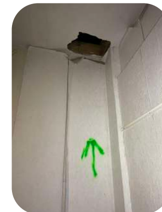
Identification des trous à obstruer
