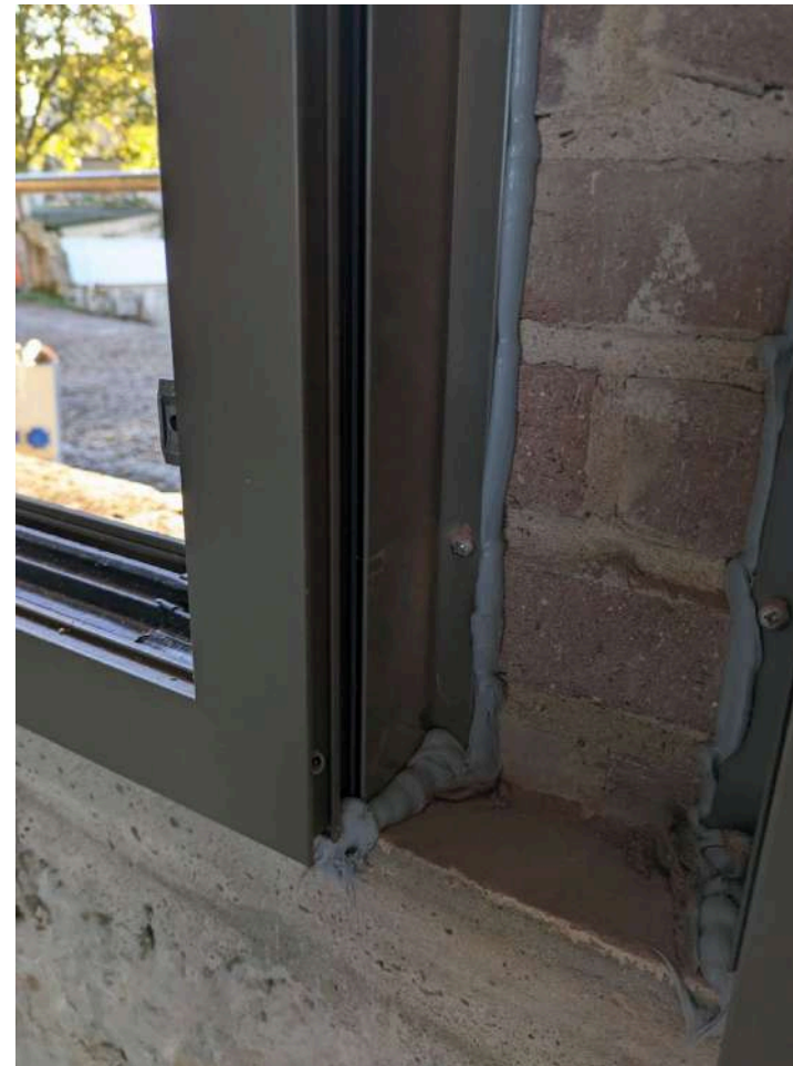
▲ Menuiseries extérieures aluminium recyclé & étanchéité
