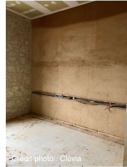
Enduit mur chauffant
