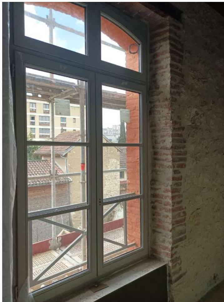
▲ Menuiseries extérieures bois
