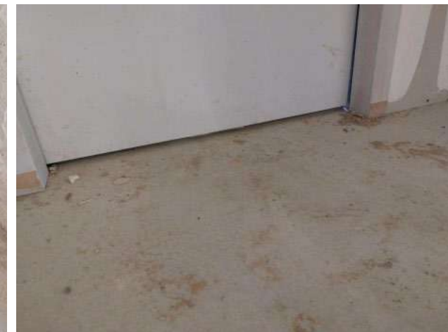
Porte donnant sur le SAS d'accès travaux
