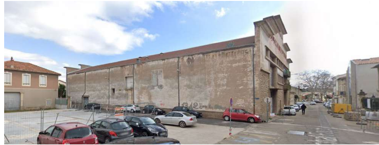
Grande Halle rue Bouschet, Ouest
