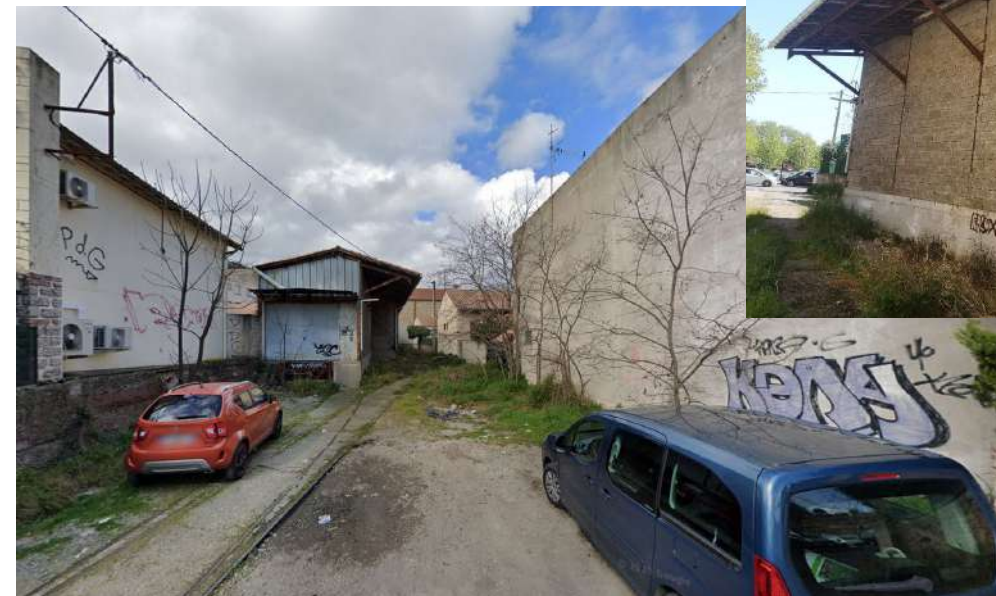
Quai de déchargement, Est
