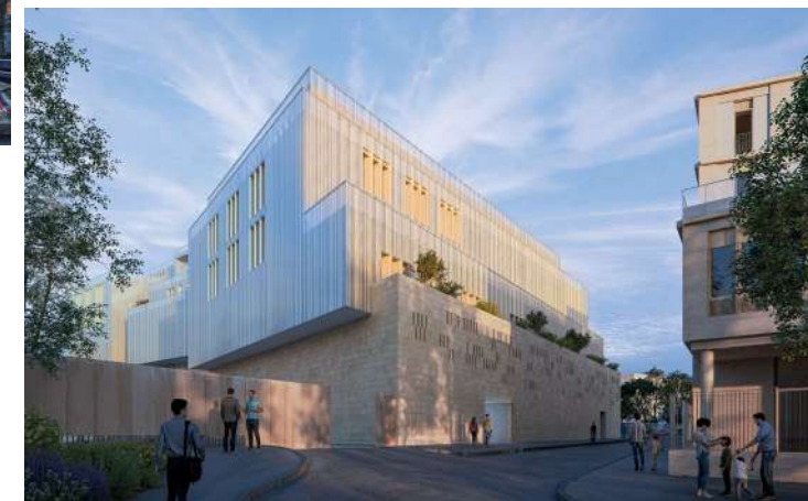
Façade Ouest rue Georges Seguy / son sous-bassement en pierre (R+2) répondant au bâtiment du groupe scolaire qui lui fait face.
