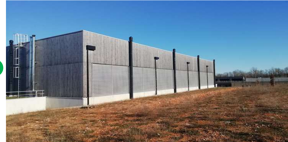
Gymnase - Façade Sud - Décembre 2025 Bardage bois douglas + Danpalon
