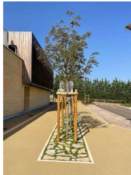
Gymnase - Façade Nord Pierres récupérées sur site
