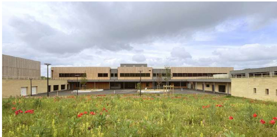
Façade Sud Collège Murs paille - Bardages bois douglas + Zinc
