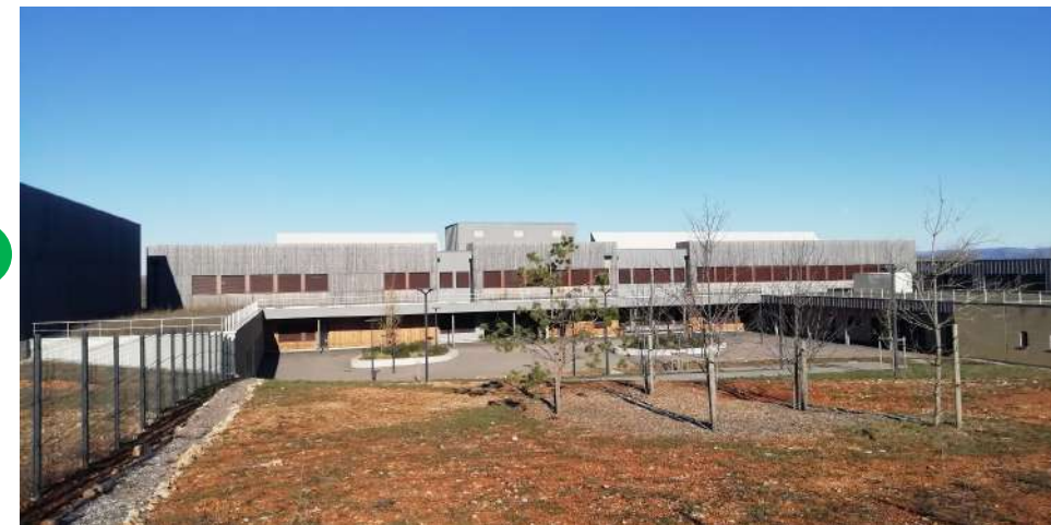
Façade Sud Collège – Décembre 2025 Murs paille - Bardages bois douglas + Zinc
