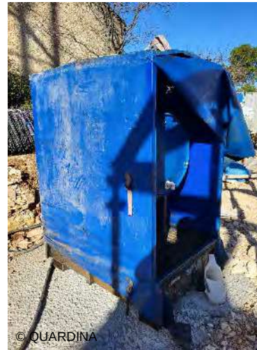
Bac de rétention de l'huile de décoffrage
