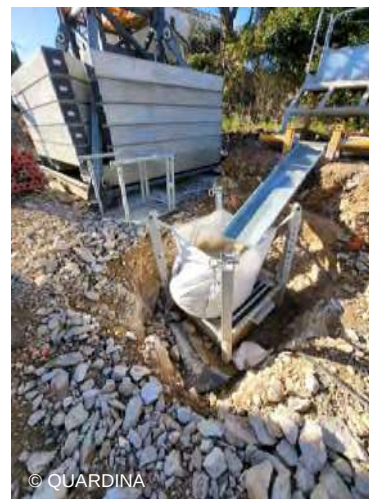
zone de nettoyage béton
