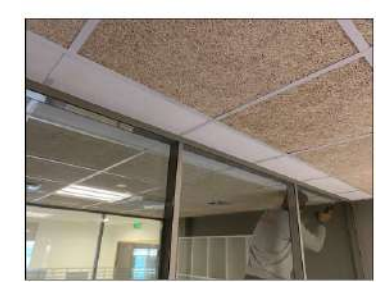
Pose d'une dalle minérale blanche en remplacement de la dalle bois
