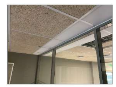
Pose d'un isolant acoustique
