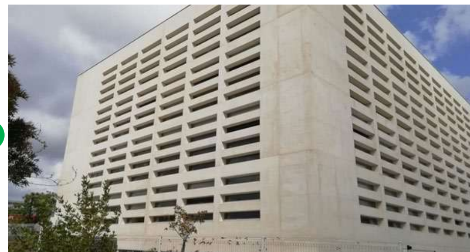
Façade Sud - Ouest
