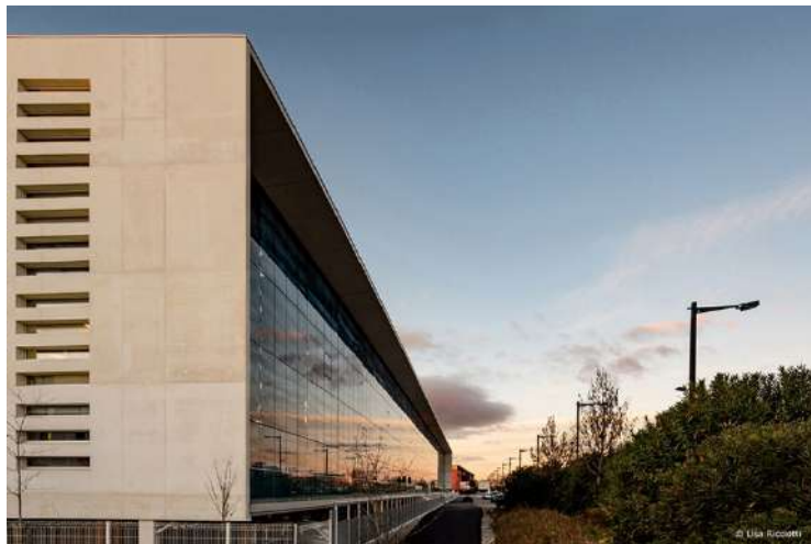
Façade Nord – Ouest – Réception chantier
