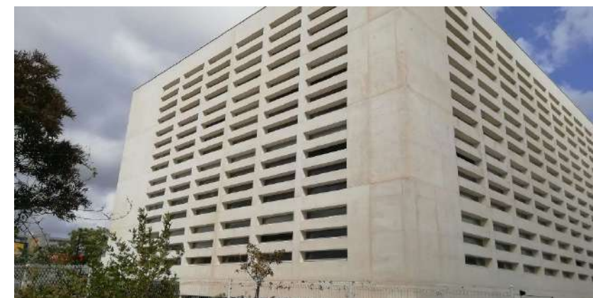
Façade Sud- Ouest
