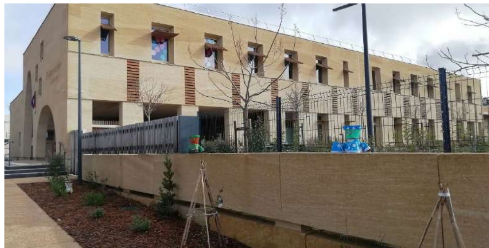
Vue extérieure sur cour élémentaire
