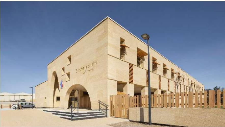
Façade Sud – Ouest – Réception chantier
