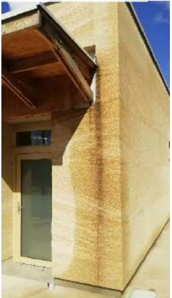
Problématique stagnation/écoulement d'eau Nettoyage de l'évacuation, contrat d'entretien annuel
