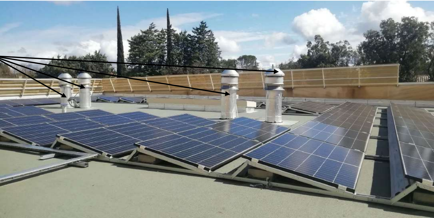
Installation de panneaux photovoltaïques – Toussaint 2024
