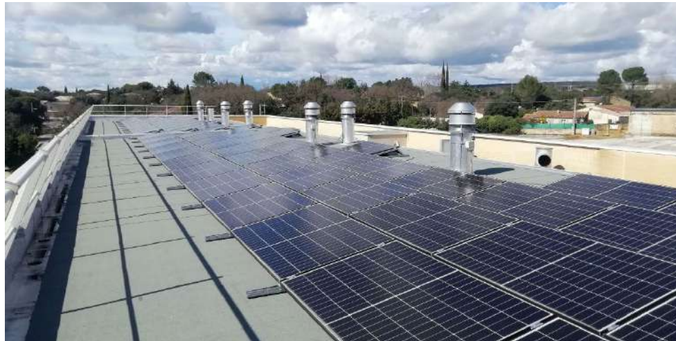
Installation de panneaux photovoltaïques – Février 2025
