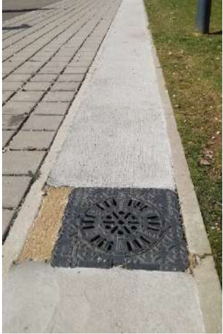
Enrobé coulé pour éviter chute d'enfant et jet de projectile
