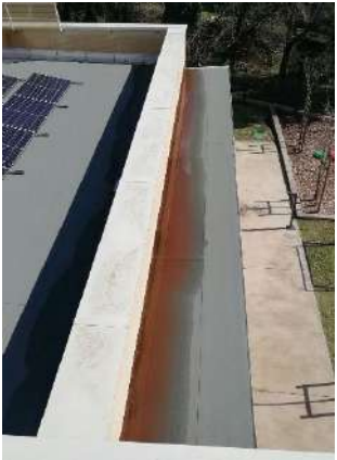
Problématique stagnation/écoulement d'eau Nettoyage de l'évacuation, contrat d'entretien annuel
