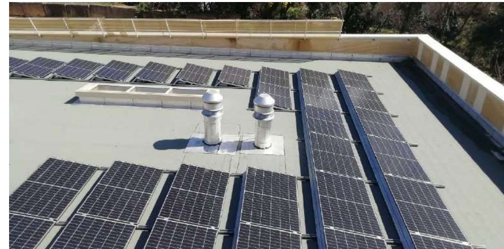
Installation de panneaux photovoltaïques – Février 2025
