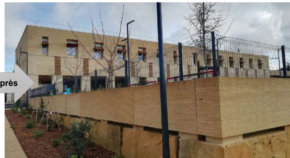
Rajout d'une clôture grillagée sur le périmètre des cours
