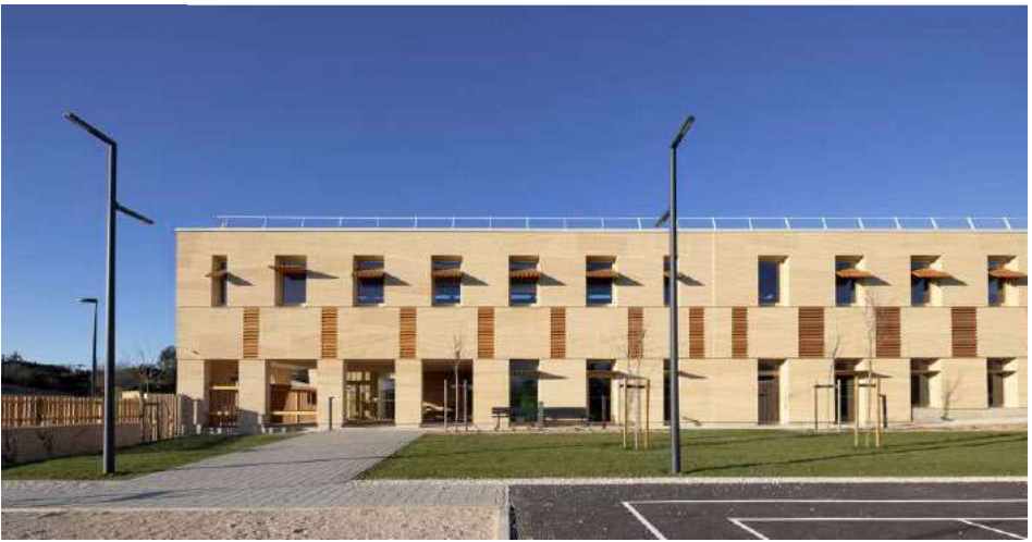
Façade Sud – Réception chantier
