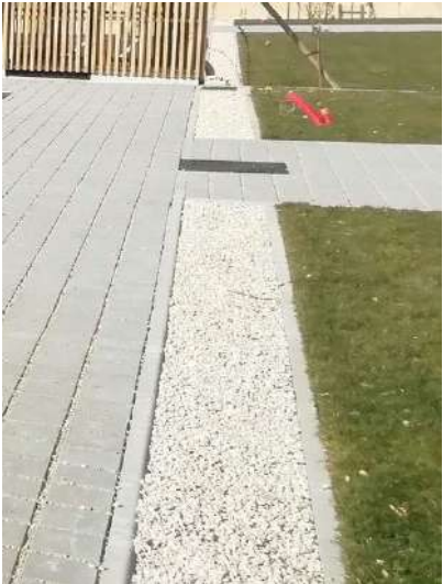
Ligne séparatrice remplie de gravier
