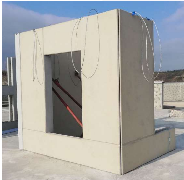
PREMURS EN BÉTON D'ARGILE (MATERRUP) issu d'un mélange d'argile non calciné et de ciment
